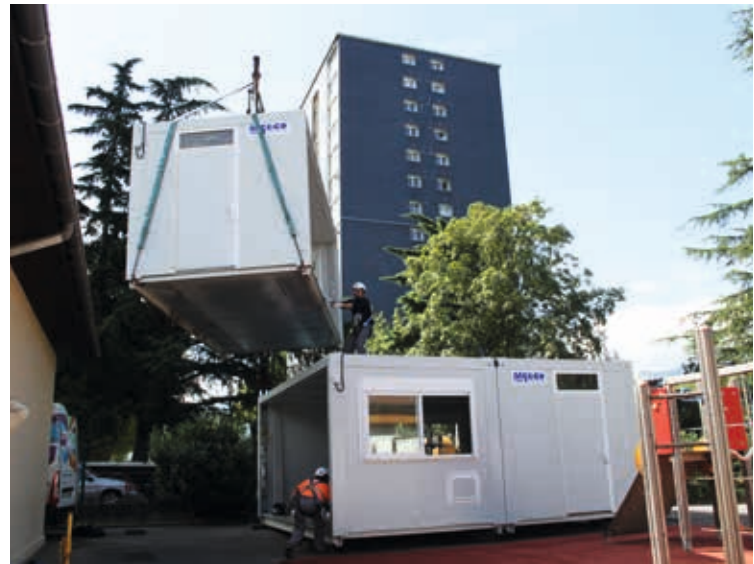
Implantation d'un préfabriqué provisoire qui abritera un dortoir dans la cour de la maternelle Delaune.
