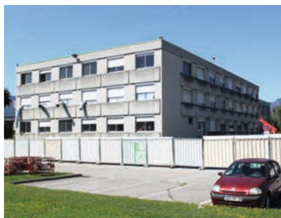
C'est à l'emplacement de l'ancienne unité de psychiatrie en cours de démolition que va être construit le bâtiment de l'extension du Centre de gérontologie Sud.
