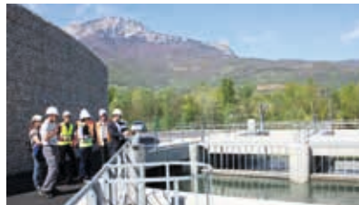
Des visites guidées vont permettre au public de comprendre le fonctionnement de la microcentrale du Rondeau.
