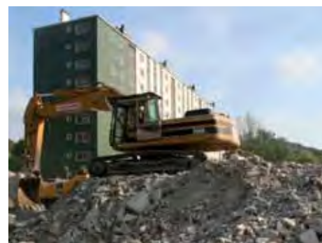
Après la démolition, place au concassage et à l'évacuation des déchets.
